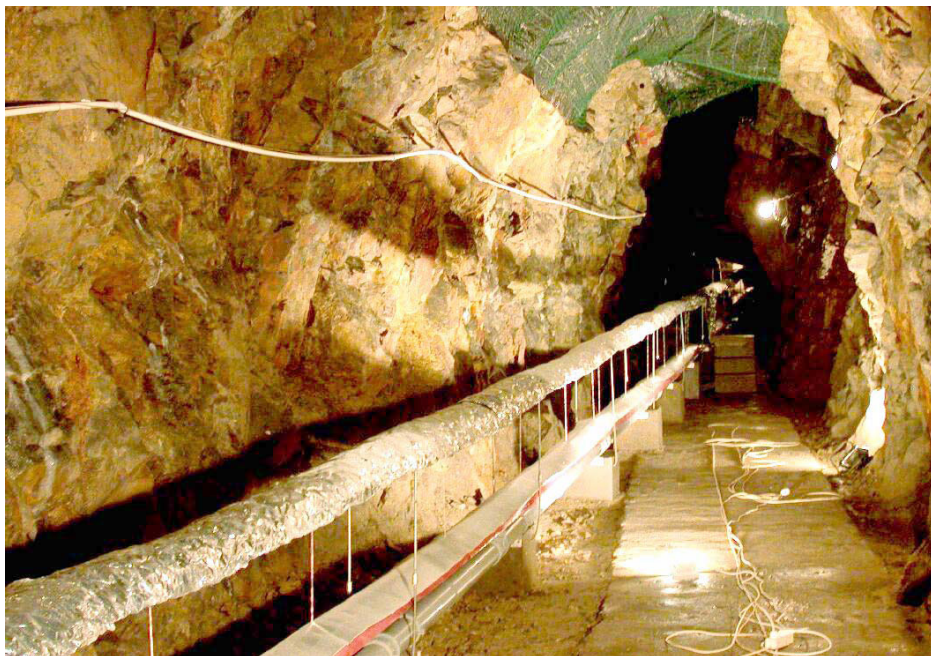
Klinometr hydrostatyczny 0304 (92 m długości) zainstalowany na specjalnym akwedukcie
