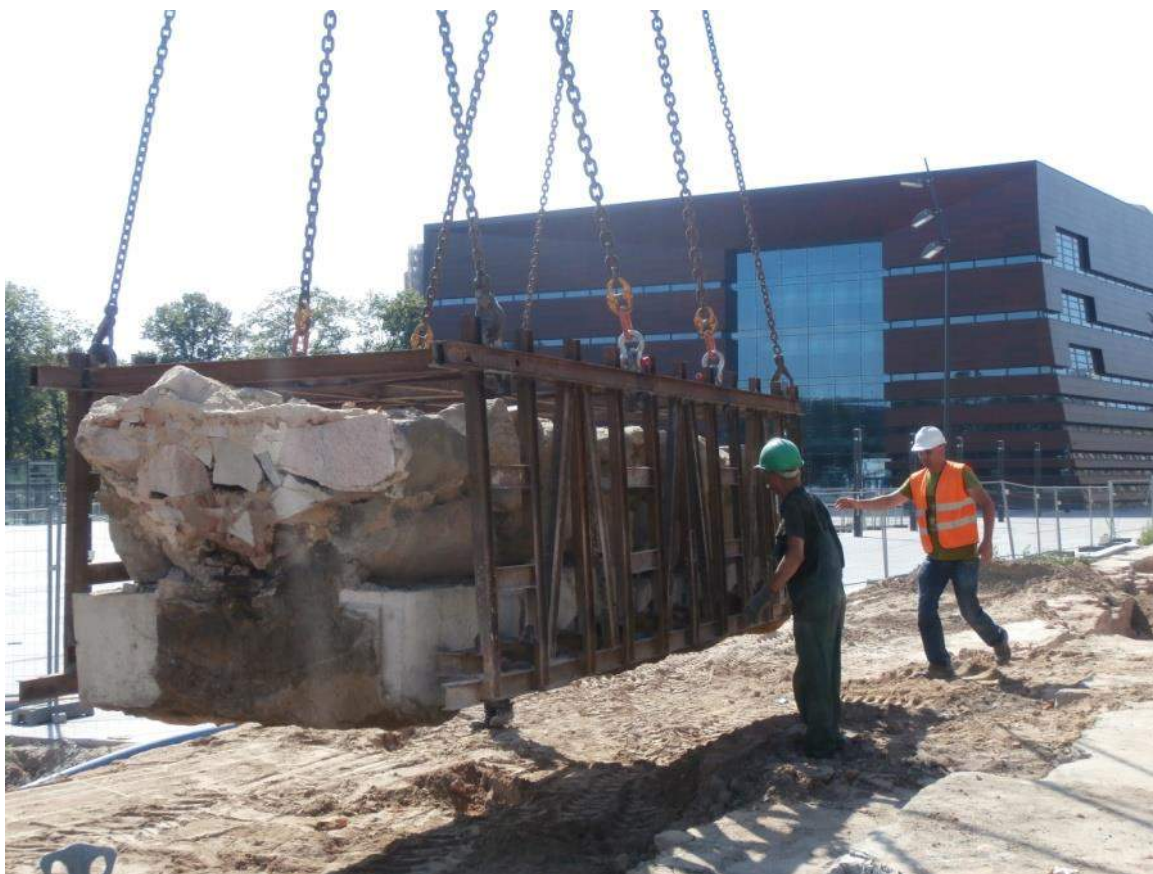
2. Wrocław, Stare Miasto, pl. Wolności. Transfer fragmentu ławy fundamentowej murów fortyfikacji, fot. T. Dziedzic
