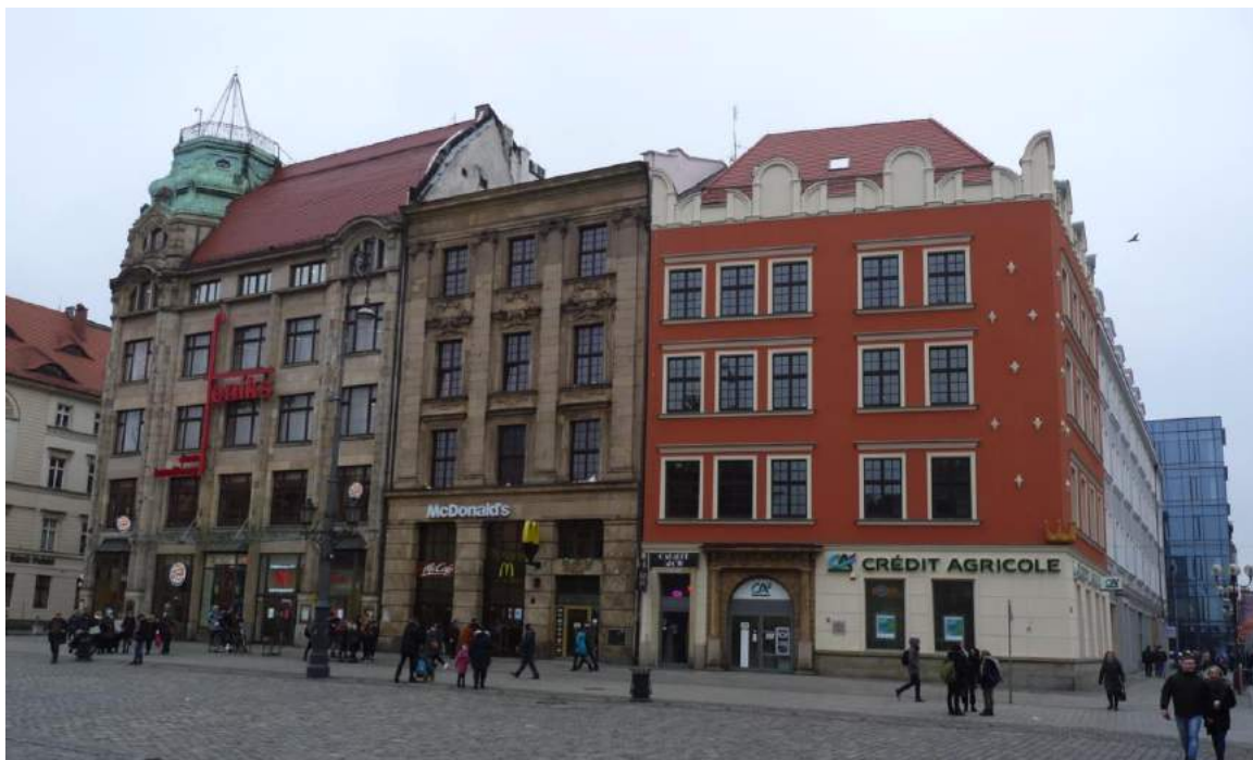
2. Dom handlowy PSS Feniks, wielofunkcyjny budynek gastronomiczno-hotelowy oraz będący w trakcie prac modernizacyjnych dom Pod Złotą Koroną, stan z 2019, fot. Paweł Kirschke
