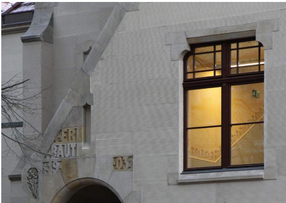
2. Konserwacja odsłoniętego napisu ERBAUT 19-03 na elewacji zachodniej i rekonstrukcja kolorystyki wnętrza klatki schodowej budynku E5, fot. A. Gryglewska, 2016
