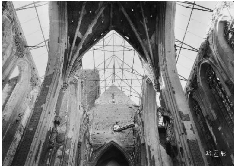
1. Stalowa więźba nad kościołem NMPanny na Piasku
