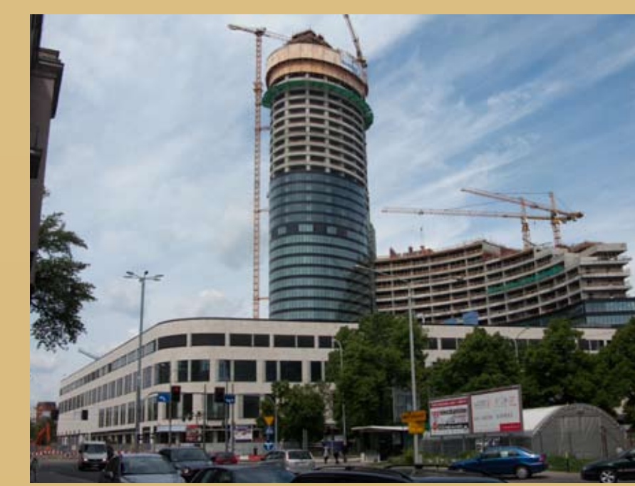
Fot. 16. Widok Sky Tower w budowie.
