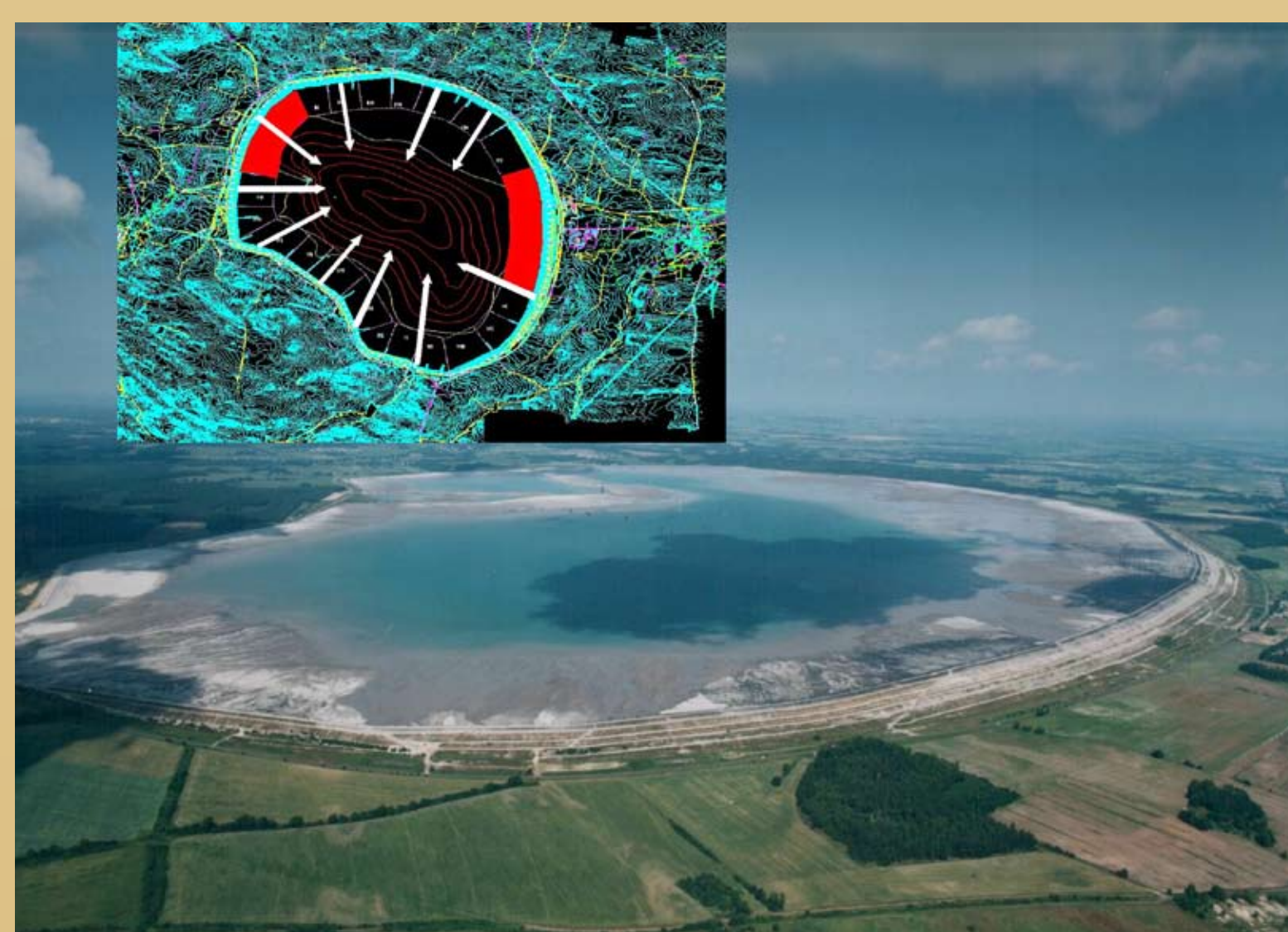
Fot. 6. Odpady pogórnictwa: 95% wydobytych i zmielonych do 60 mikrometrów skal okruszczonych. Problemy geotechniczne, transportowe, ochrony środowiska. Widok na Żelazny Most, 392 mln m 3 odpadów flotacyjnych zawierających ok. 0,2% Cu (Grotowski).
